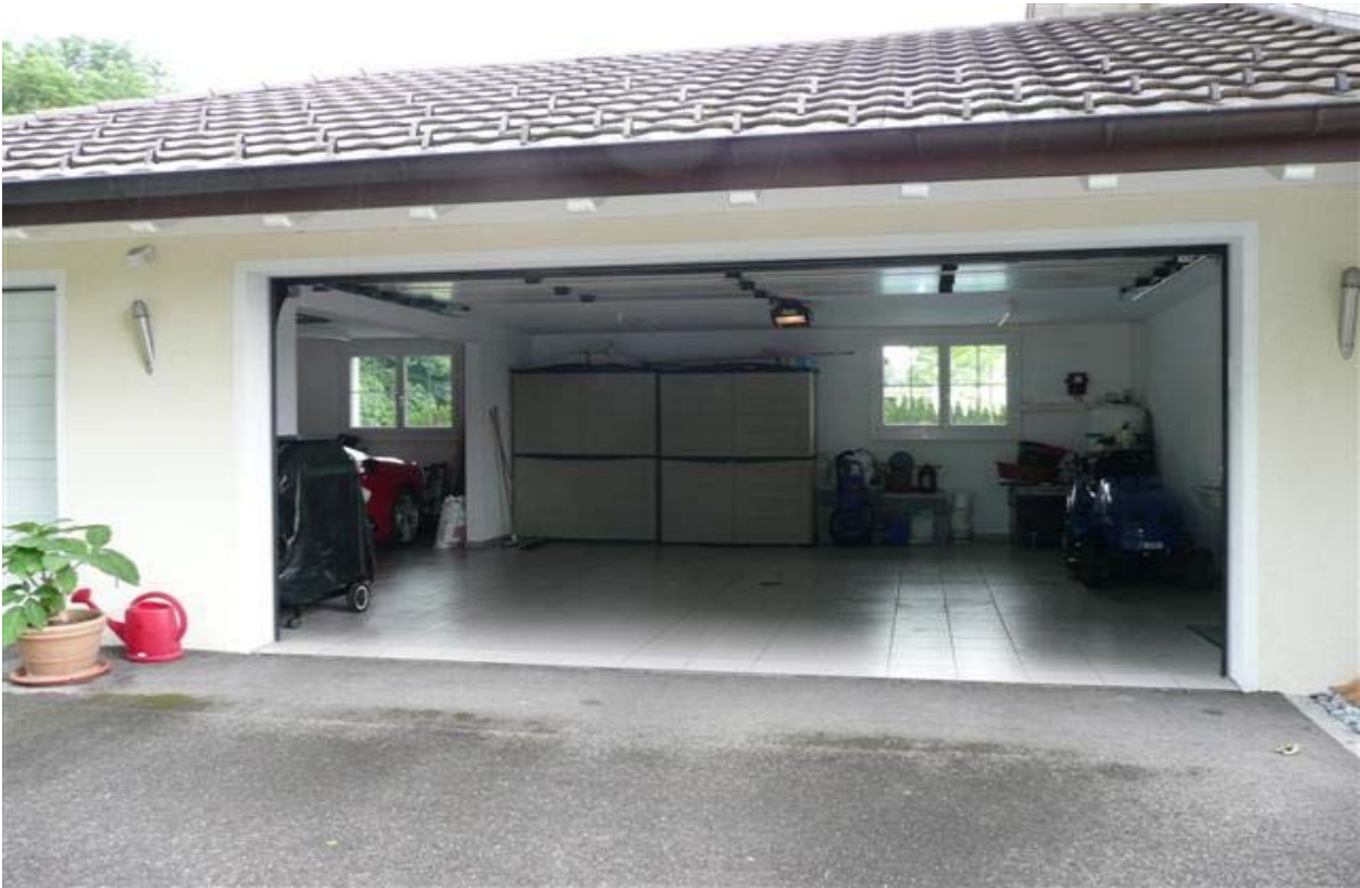
Garage für 3 Fahrzeuge mit elektrischem Torantrieb
